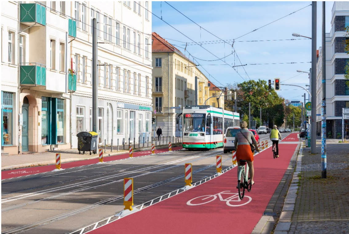
Abbildung 12: Variante 1, Verwendung von Leitelementen in größerem Abstand, durchgängiger Radfahrstreifen
